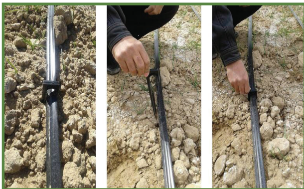
شکل ۱۵- مهاری نوارهای آبیاری با گیره در روی زمین
