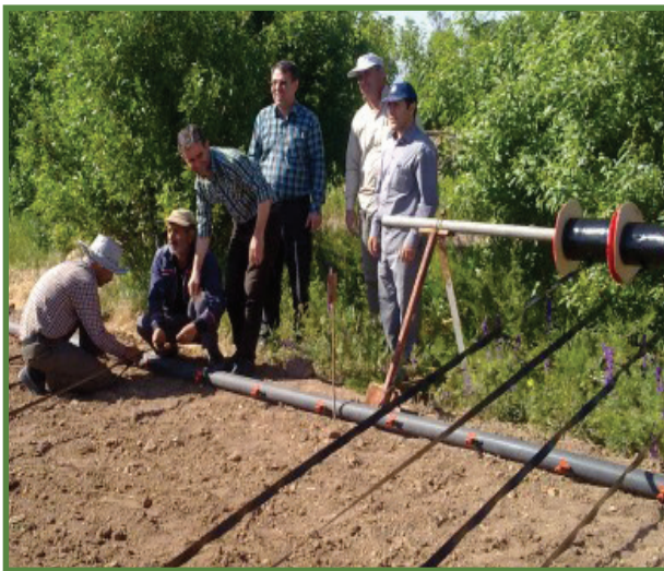
شکل ۲۱- نصب دستی نوار آبیاری قطره‌ای
