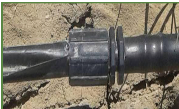
شکل ۱۲- نحوه اتصال نوارهای تیپ به لوله ۱۶
